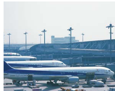
関西国際空港ターミナルビル
